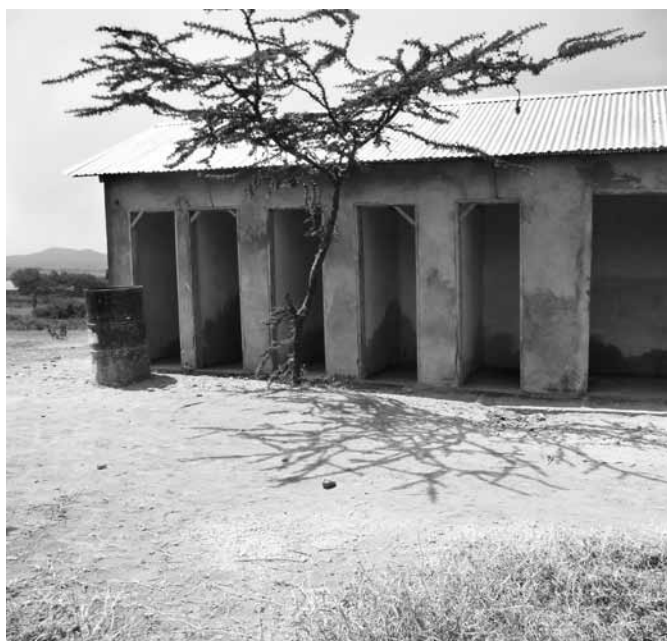
Kurz vor der Fertigstellung: Die neue Toilettenanlage an der KPS.
