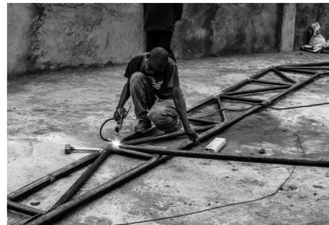
Die Dachträger werden vor Ort fachmännisch zusammengeschweisst.
