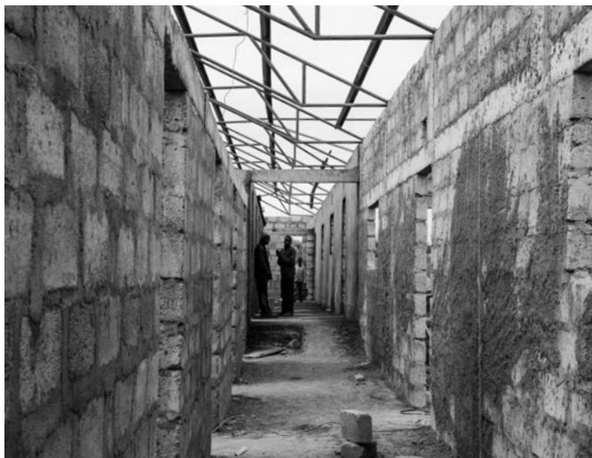
Die Mädchenunterkunft an der Primarschule im Rohbau
