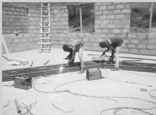
Der Bau der Dining Hall an der KPS ist bereits weit fortgeschritten: Die Träger für die Dachkonstruktion werden vor Ort zusammen geschweisst.
