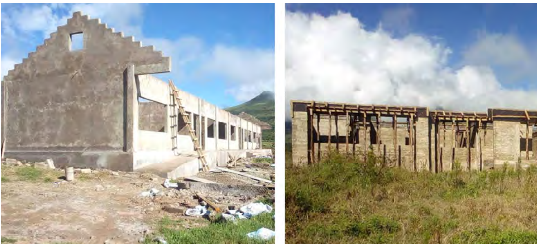
Bild: Unterrichtsräume (links) und das Administrationsgebäude (rechts)
